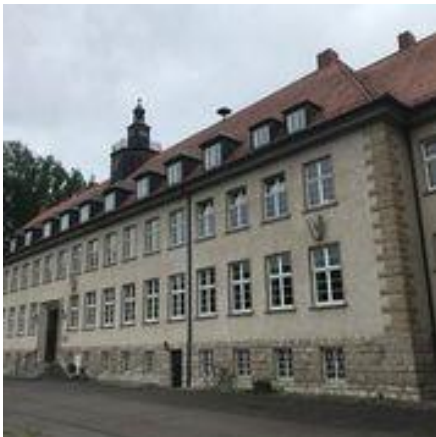
Abb. 3: Seit 1929 steht der Neubau des Gymnasiums in der Nähe des Bahnhofs der Stadt Heiligenstadt. Foto: Dr. Torsten W. Müller.
